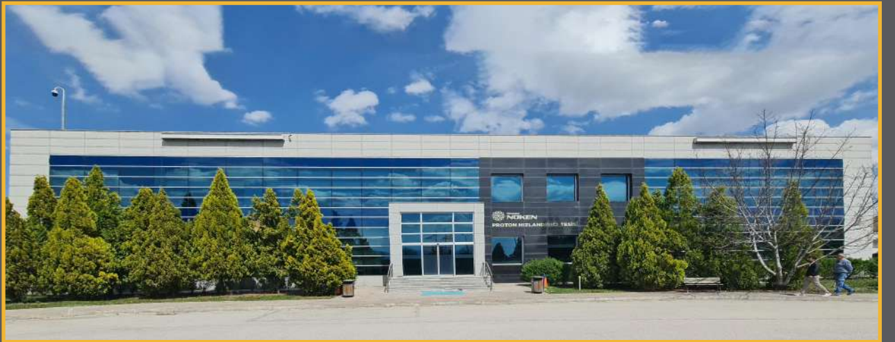
TENMAK-NÜKEN Proton Hızlandırıcı Tesisi
